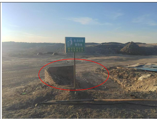
生活垃圾暂存池破损且未封闭
