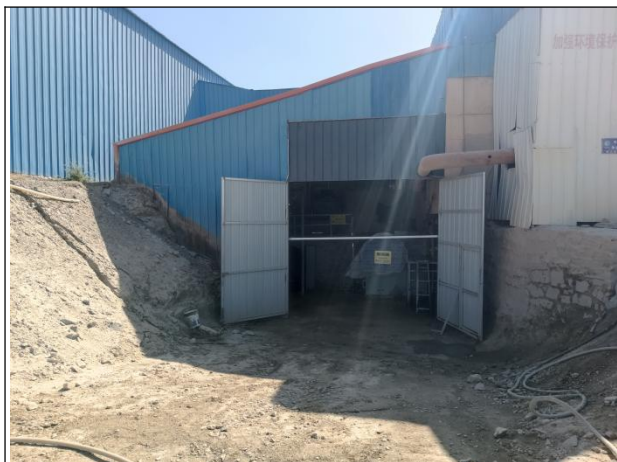
设备安装在车间内
